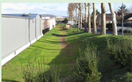
Espaces verts de type «Raingarden»
